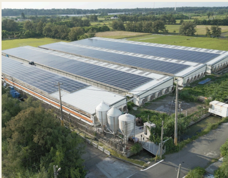
▲ 將鵝舍與綠電結合，透過綠電創造穩定現金流，並保留部分屋頂透光，兼顧鵝的健康。圖片來源：向天歌
