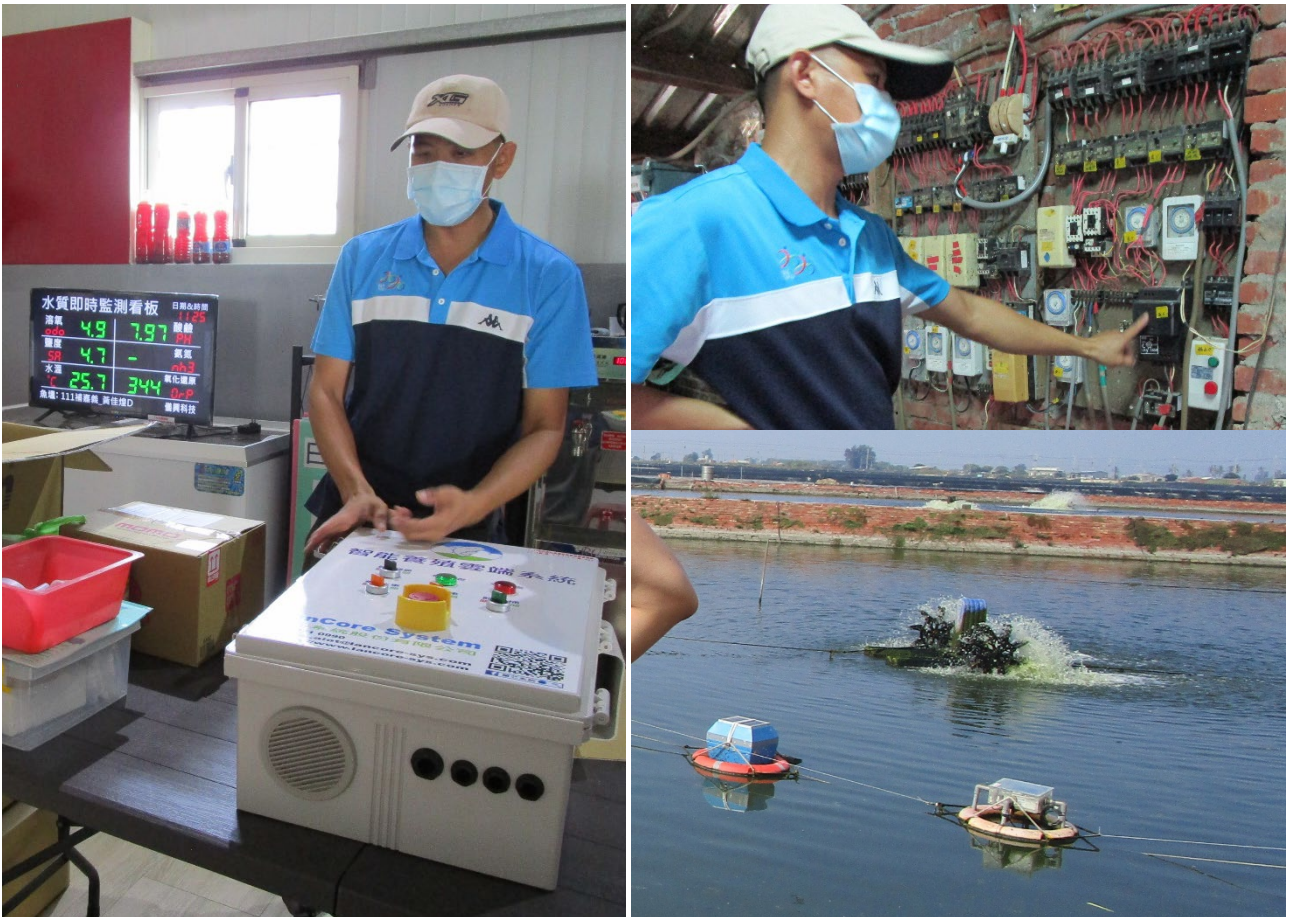
圖 2 左：場主展示新購置的智慧電箱，在他身後有一個水質監測看板正即時輪播資訊 右上：魚塢的控制室內可見控制各種設備的電子開關 右下：魚塢中的變頻水車與水質檢測設備
