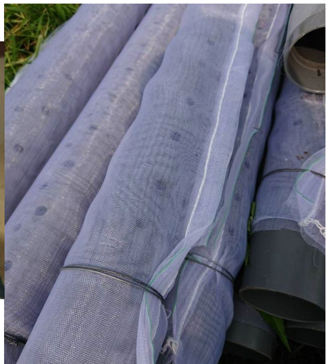
圖 3 暗渠系統 PVC 管鑿孔與包覆紗網
